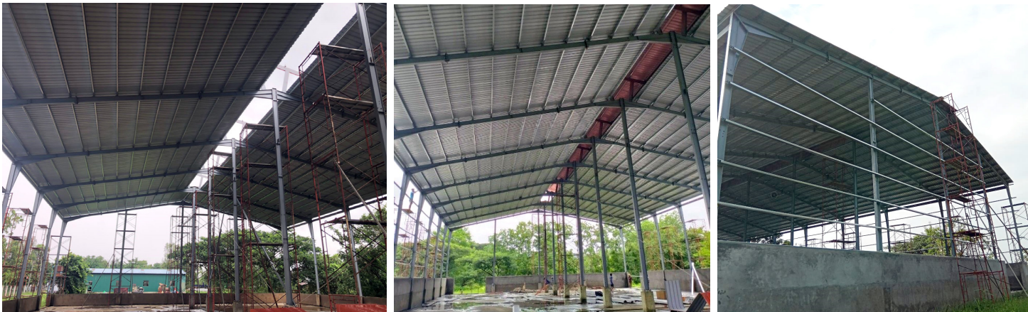
တွံတေးတွင် တည်ဆောက်နေသည့် သိုလှောင်ရုံအဆောက်အဦး
